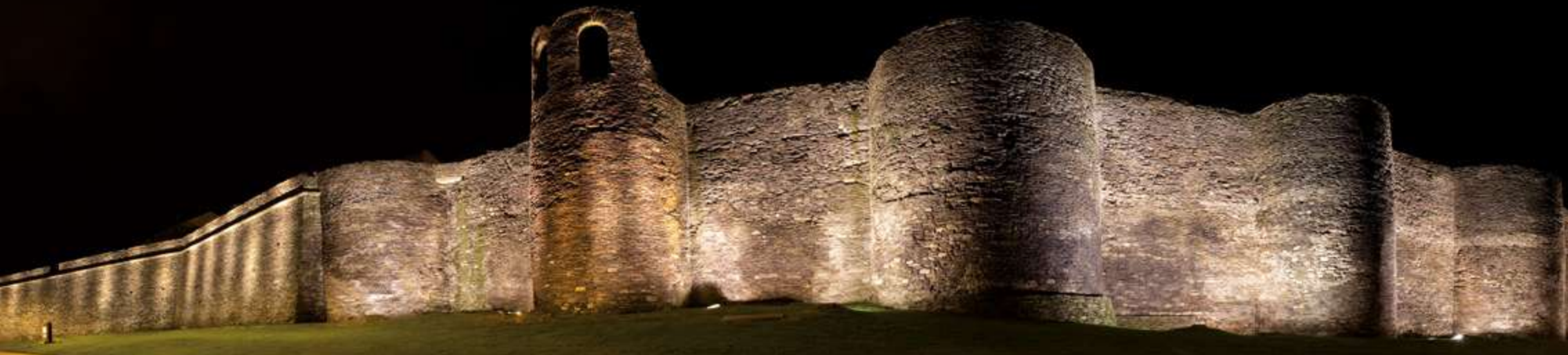
RÖMISCHE STADTMAUER IN LUGO
